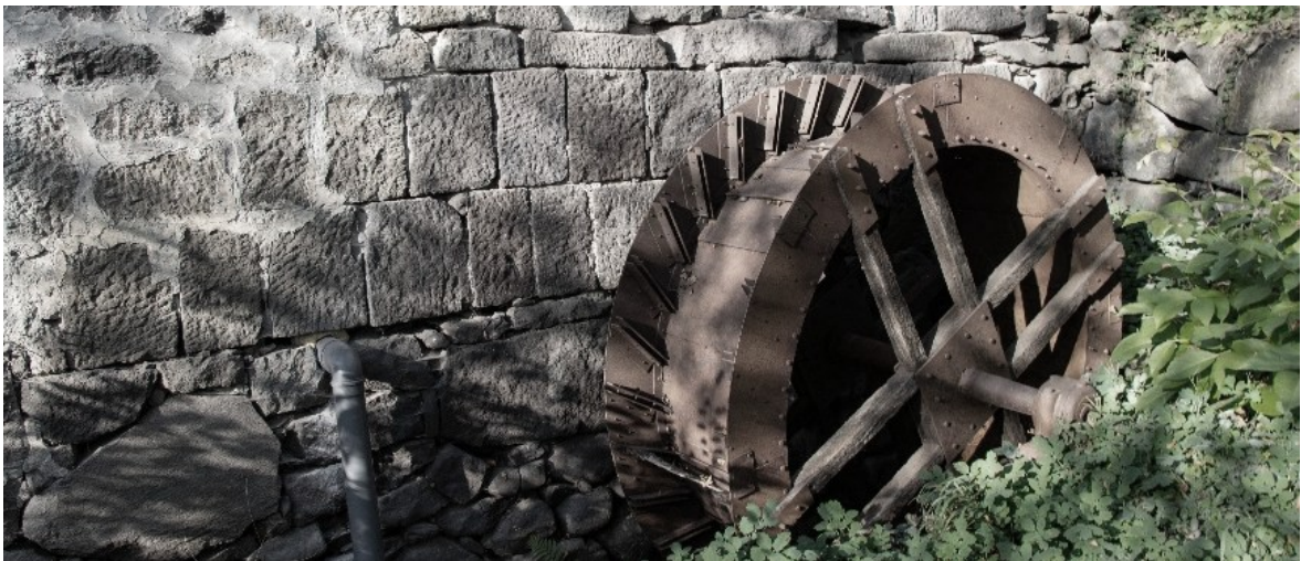
11. ábra: a görgényüvegcsúri malom fémvázaskereke [39]
