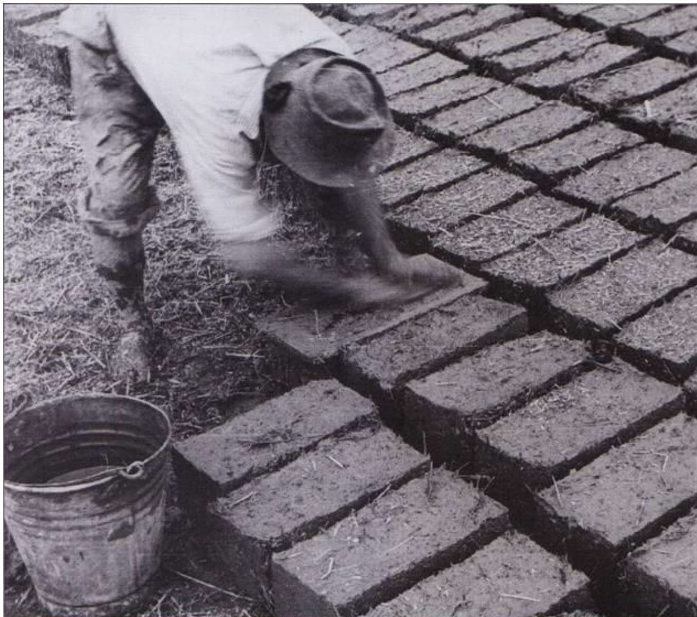
9. Kép: Vályogvetés, Tiszaigár, 1949. fotó: Bakó Ferenc [15]
