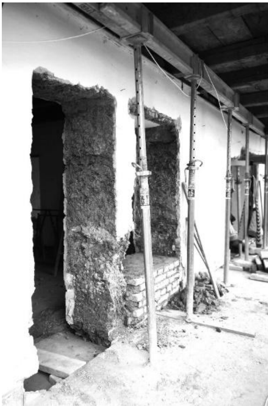
45.Kép: Új nyílások a földfalba, fotó: Bordás Mónika [24]
