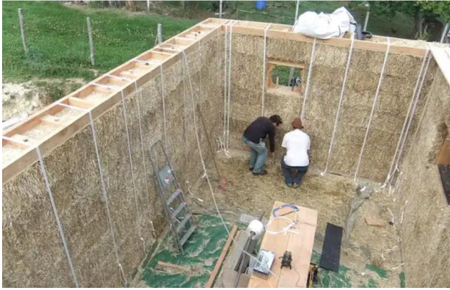
5. ábra, 6. ábra- Önhordó szalmafalak előnyomása [25.]
