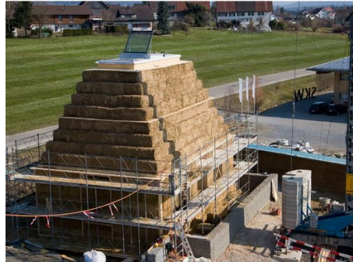
11. ábra- irodaépület – konzolos boltozatos szerkezetű szalmabála-ház [29.]
