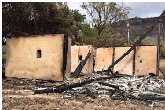
1-2. ábra- Egy Kaliforniai tűzvész előtt és után, a fa díszítések és a tető leégett, de a megfelelő tapasztást kapott szalmafalak állnak. [43.]
