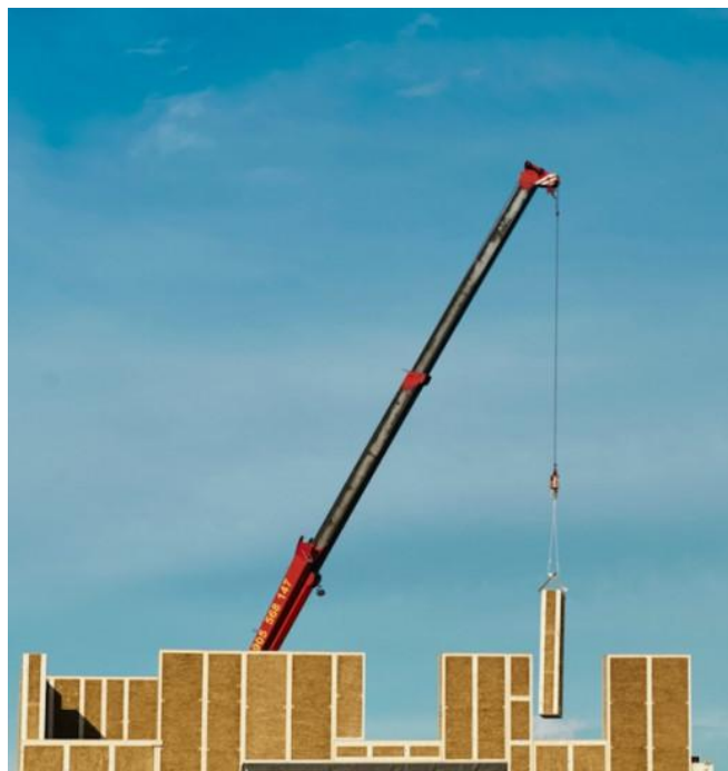
10.ábra- EcoCocon rendszer szerelése [32.]
