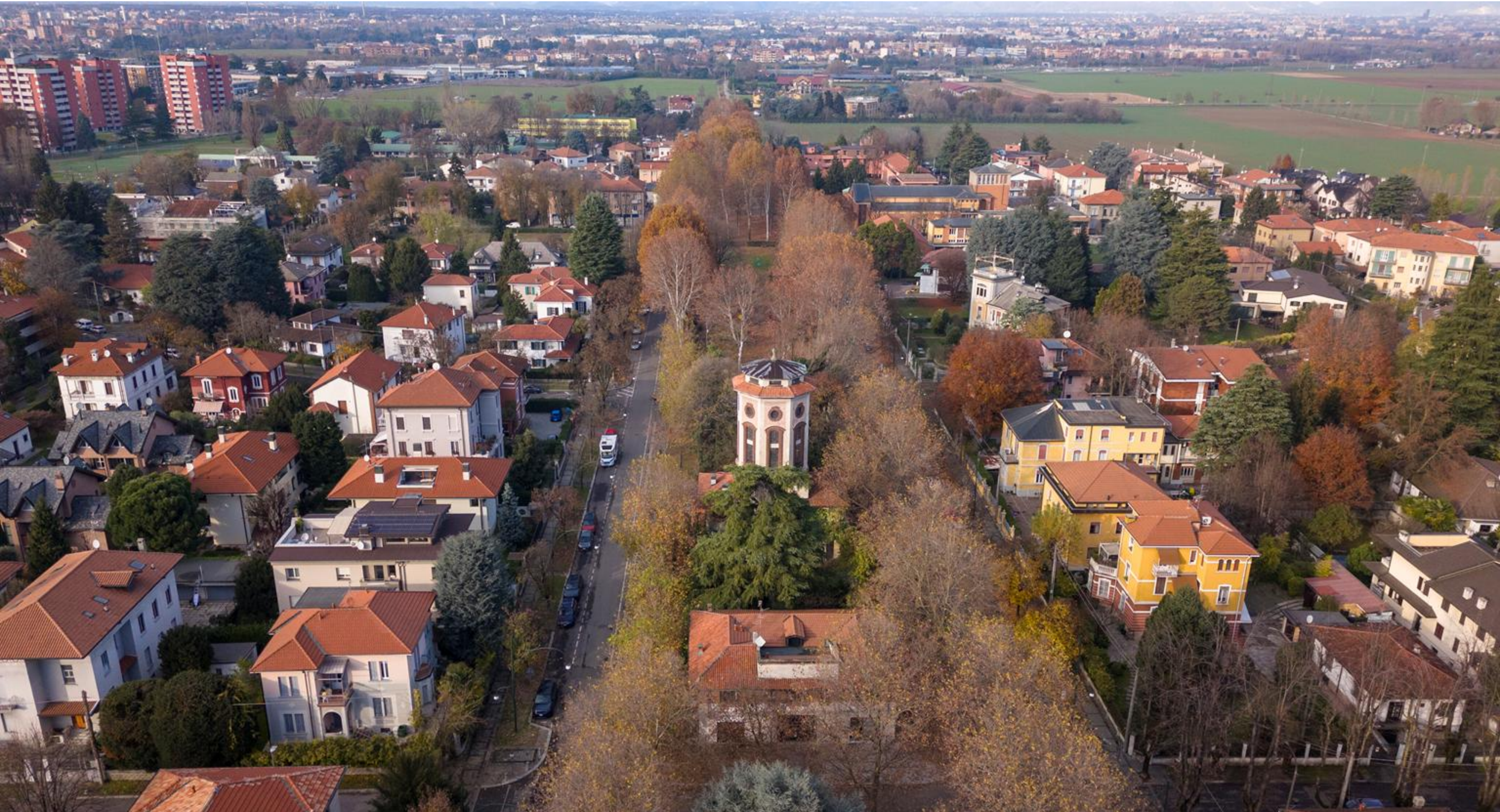
TÁVLATI KÉP - VÍZTORONY ÉS KÖRNYEZETE
