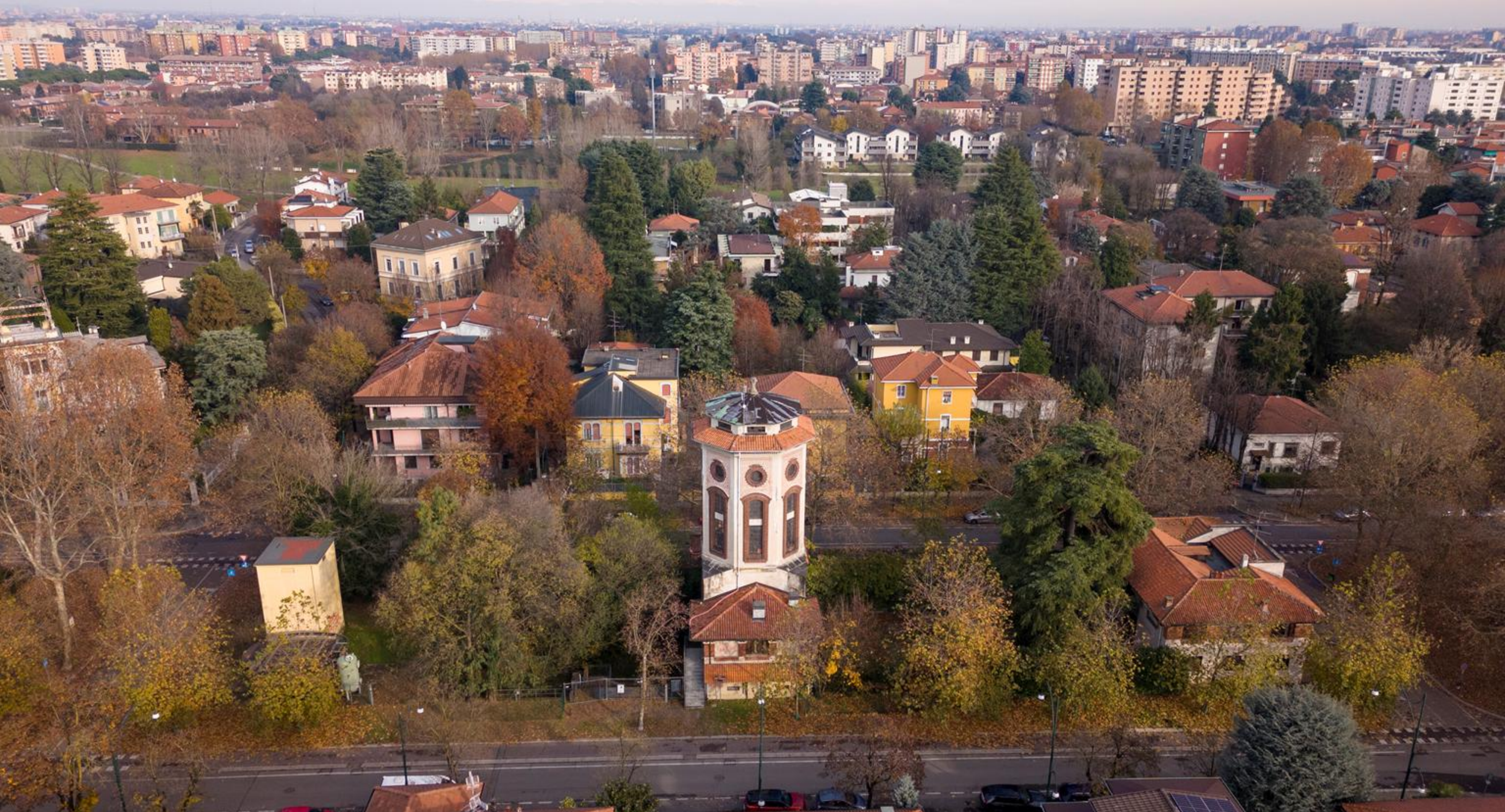
TÁVLATI KÉP - VÍZTORONY ÉS KÖRNYEZETE
