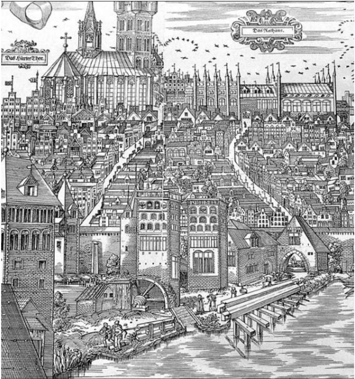
Részlet Elias Diebel 1552-es lübecki városképből. Jól megfigyelhetők a Huxterdammnál álló sörfőző (Braucher) és kereskedő (Kaufleute) víztornyok, valamint a gépészeti háttérrel biztosító, folyóvíz által hajtott vízkerék
