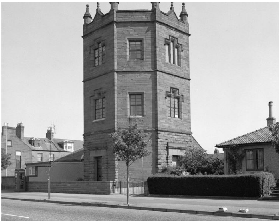
A William Middleton által tervezett Lochside Cistern (Montrose, Skócia, 1841). A korai ipari építészetre jellemző historizáló, neogótikus erődítmény-karakter
