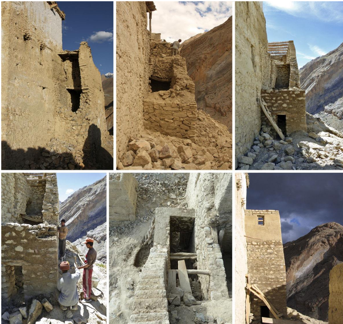
26.kép Felújítás előtti, alatti helyszíni képek
